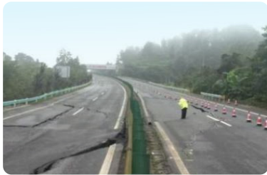
路基沉降监测
